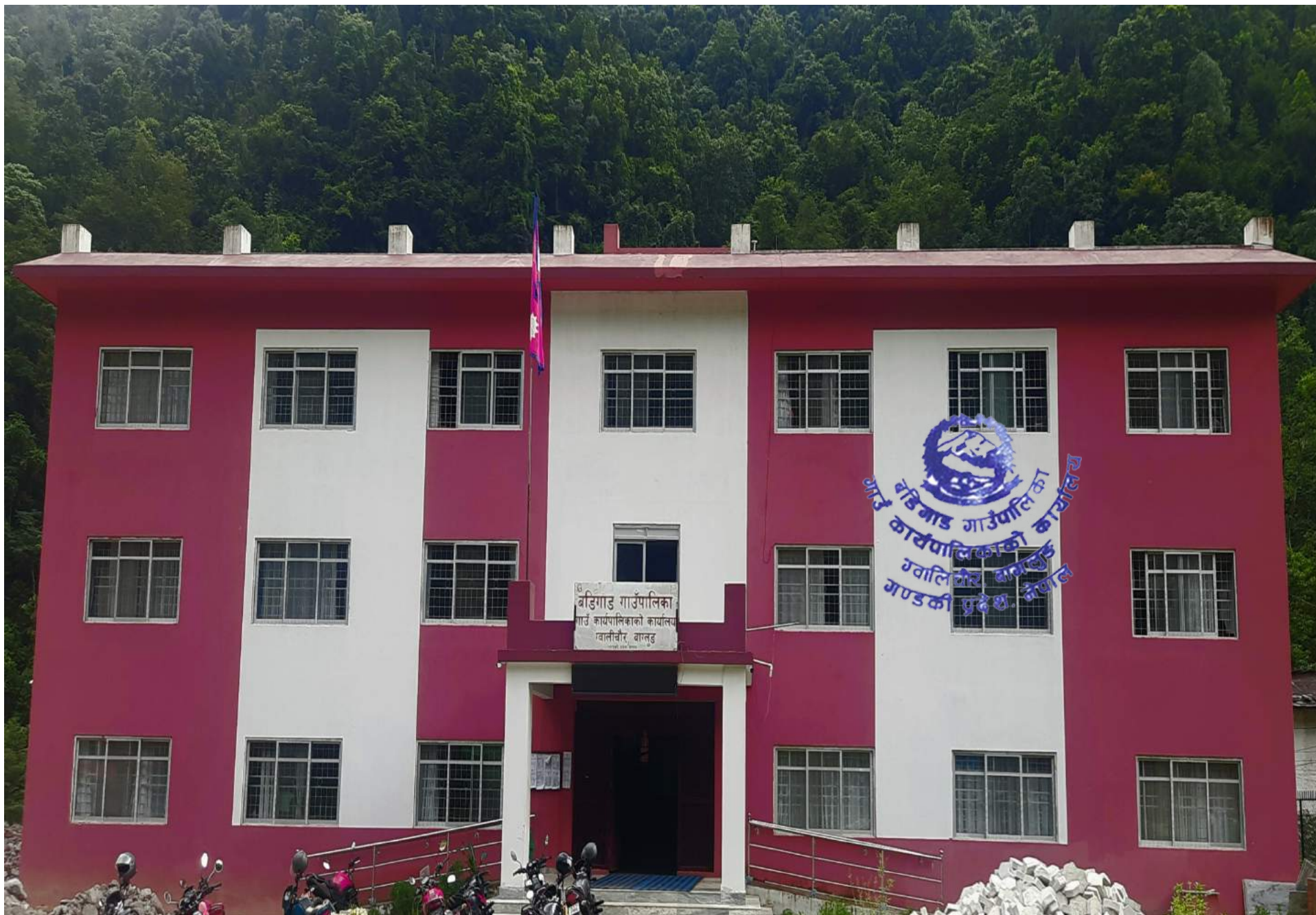
बडिगाड गाउँपालिकाको प्रशासनिक भवन
